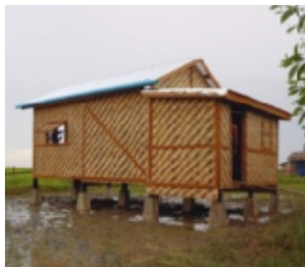
Nye pælehuse bygget efter traditionel byggestil og på solide fundamenter af beton.
